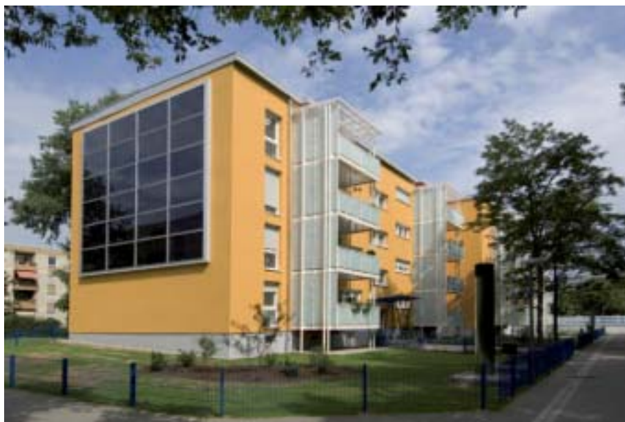
Aquest és un dels edificis que fa servir el sistema dels tres litres ideat per la multinacional BASF
